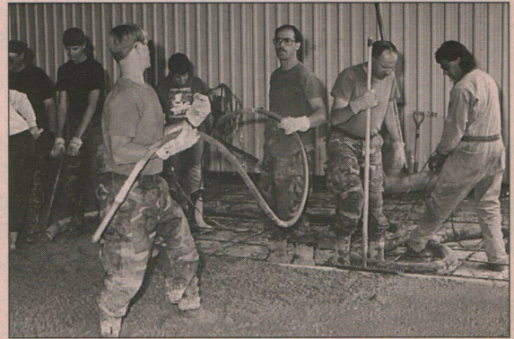
ANG Pouring the floor at P-16.
