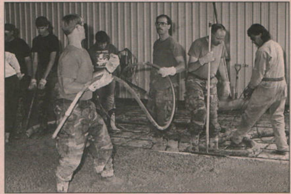
ANG Pouring the floor at P-16.
