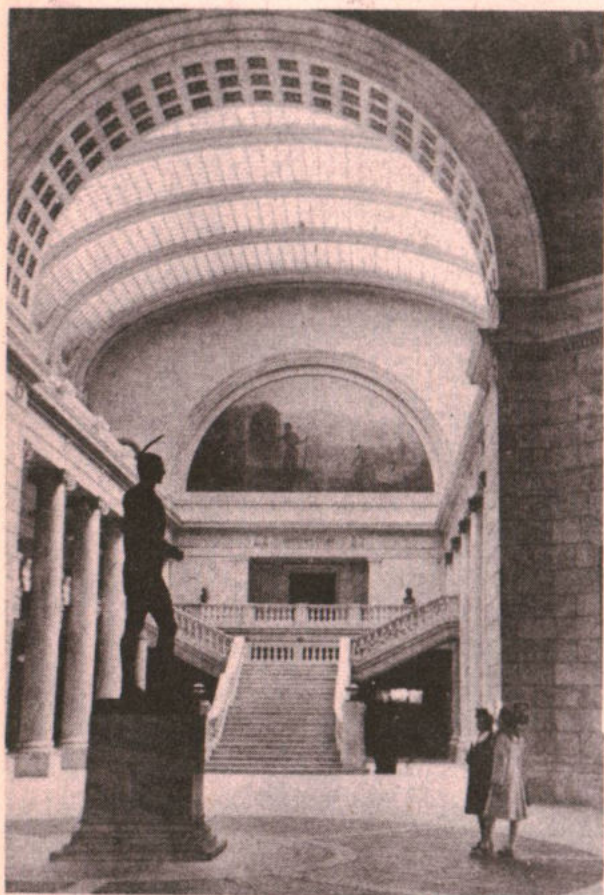
INTERIOR 'UTAH' STATE CAPITOL
